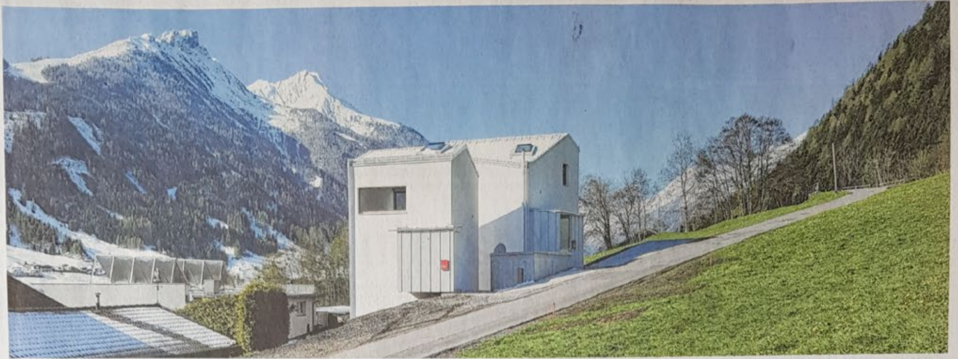
Wie gut gepflegte Backenzähne ragen die zwei Einheiten mit ihren reizvoll verschobenen Satteldächern aus dem Steilhang. Baustoffe sind Beton und Ziegel, die nach außen gestülpten Eingänge sind Holzboxen.
